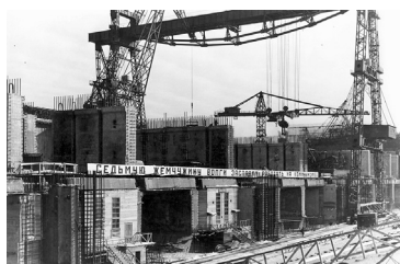
Монтаж здания ГЭС в зоне ГА 6-7
